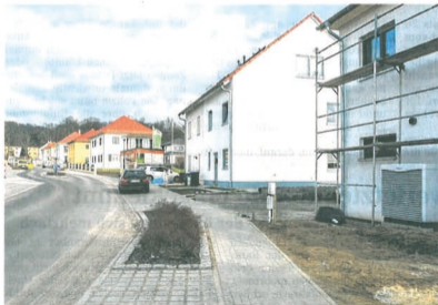
An der Lessingstraße wurden die ersten Einfamilien- und Doppelhäuser bereits bezogen. Foto: Martin Förster
