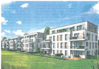
Fünf moderne Stadtvillen entstehen ab März an der Schlegelstraße. Visualisierung: SWG GmbH
