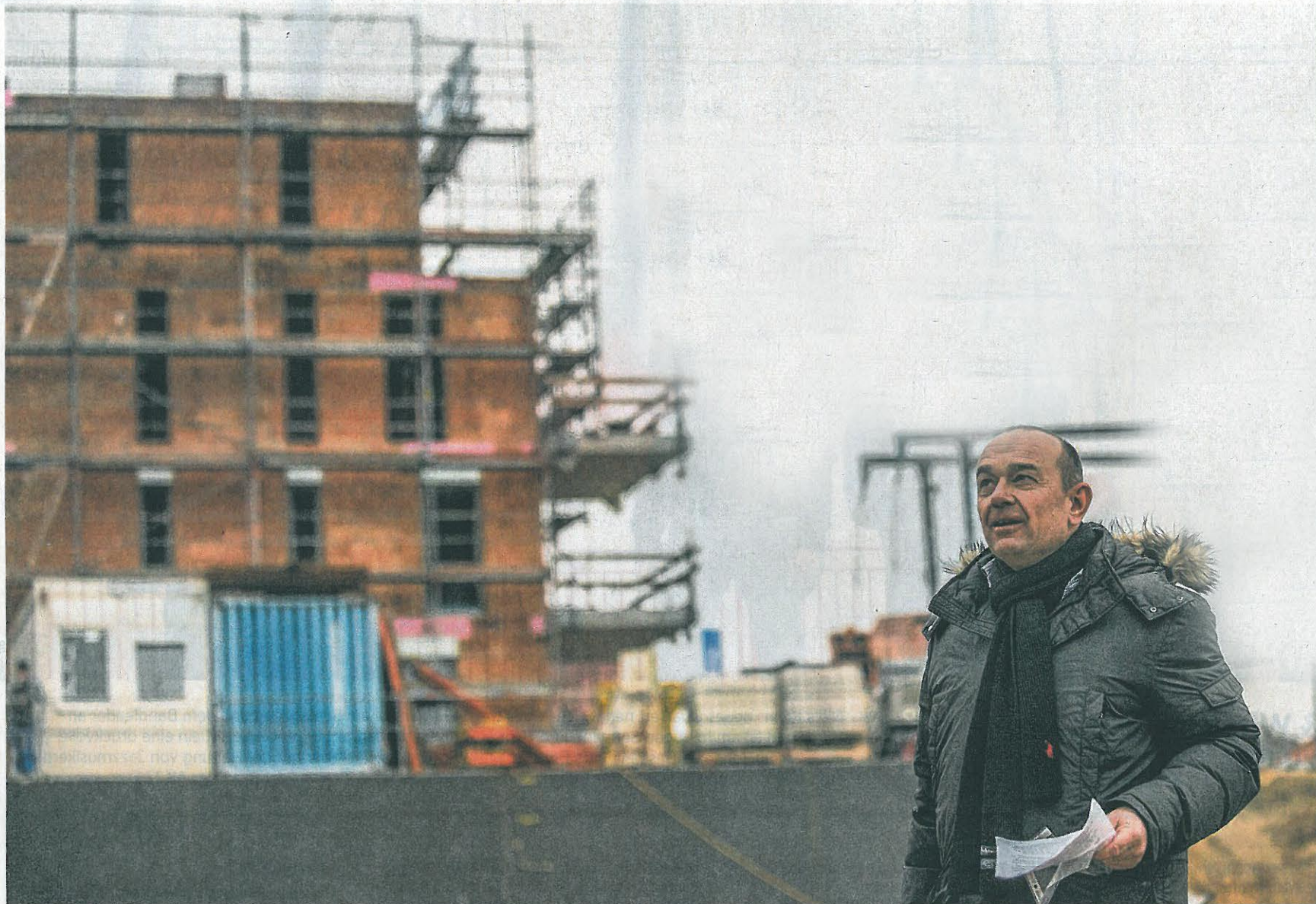
SWG-Chef Peter Heil baut an der Schlegelstraße fünf Apartmenthäuser. Auf zweien von ihnen konnte er gestern Richtfest feiern, für die übrigen drei legte er den Grundstein.
